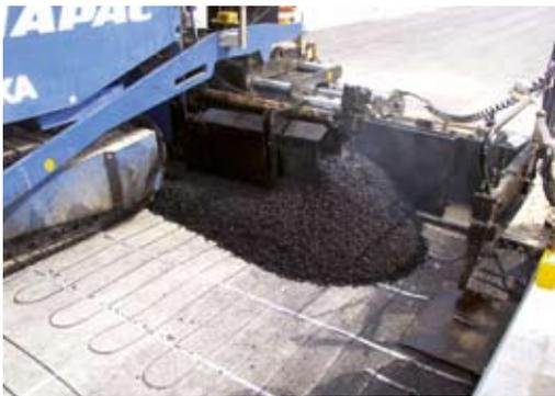
EM2-MI est la solution idéale en cas d'asphaltage à haute température. Les autres câbles chauffants ne résistent pas à des températures aussi élevées.
