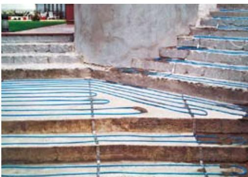
Modèle de flexibilité, le EM4-CW se pose aisément sur les surfaces de forme irrégulière. Une excellente solution pour les escaliers de secours.
